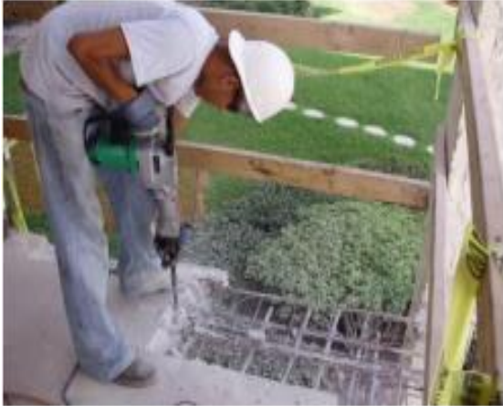
Figure 2.3 – Enlèvement du béton selon la norme EN 1504-10
