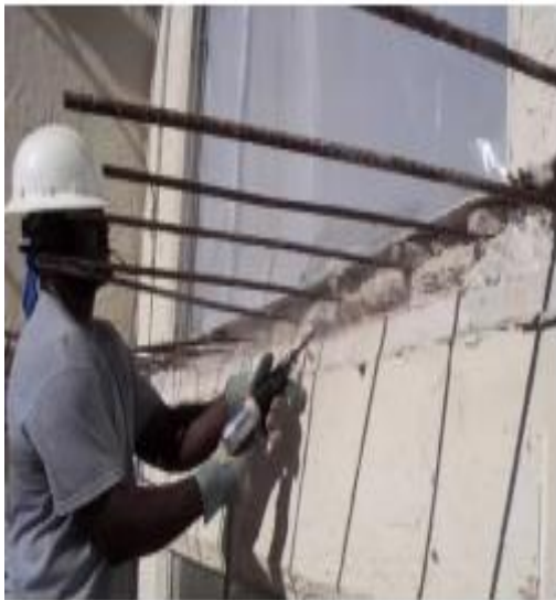
Figure 2.7 – Nettoyage des barres d'armature.
